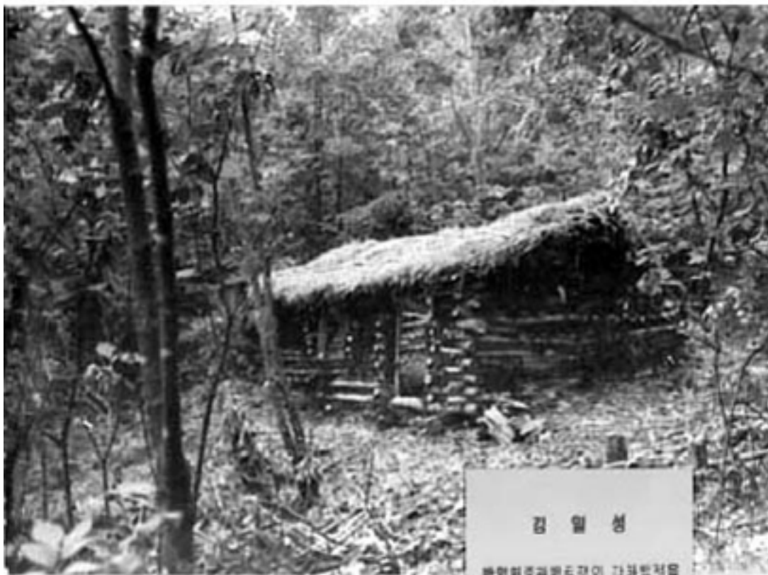
Sitio donde se efectuó la Conferencia de Nanhutou.
